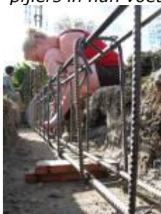
De funderingsbalk bevestigen...
