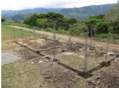
De fundering gegraven, de pijlers in hun voetstuk gegoten
