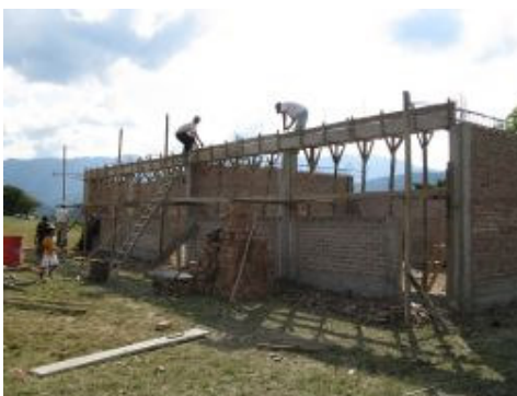
Hoogtewerk om de bovenbalk in elkaar te steken
