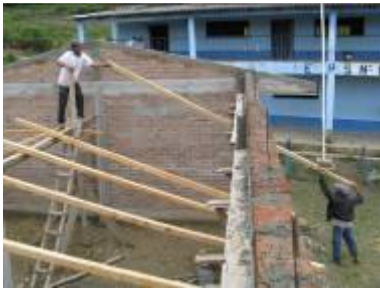
Eerst de structuur van het dak
