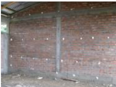
De muren worden voorbereid om te pleisteren
