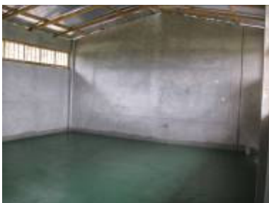
De vloeren worden gelegd, met de hulp van de leerkrachten.
