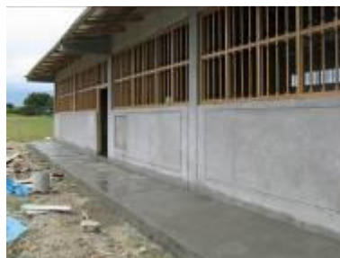
De timmermannen komen de ramen en deuren installeren.
